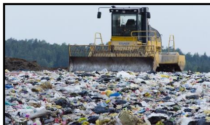
SW.1 (ii) Будівництво установки механіко-біологічного очищення
