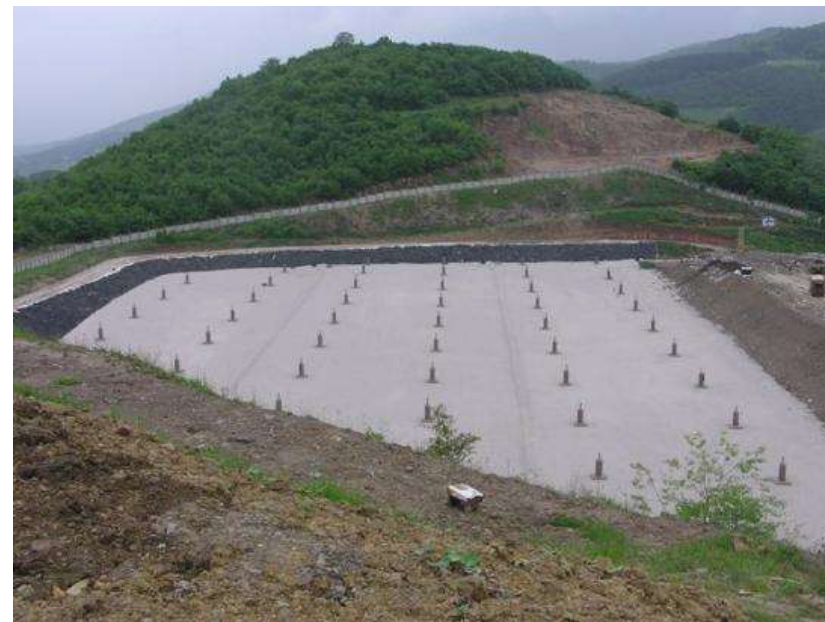
Slika 27. Pokrivanje deponije
