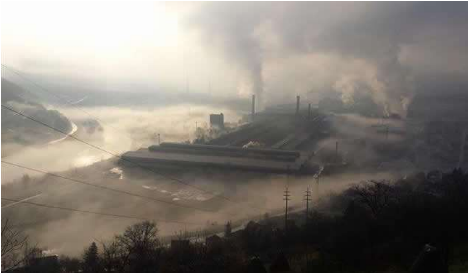
Slika 6. Pogled na tvornicu AMZ
