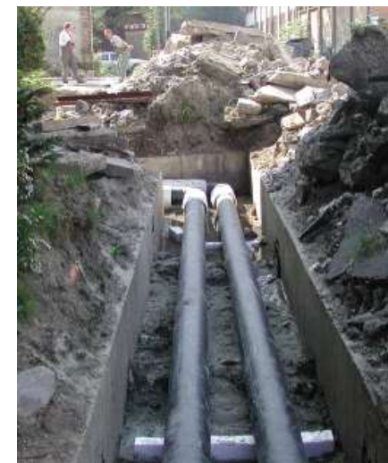
Slika 11. Ugradnja nove mreže cijevi toplovoda
