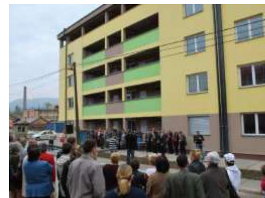
Slika 13. Nedavno završeni projekat utopljanja
