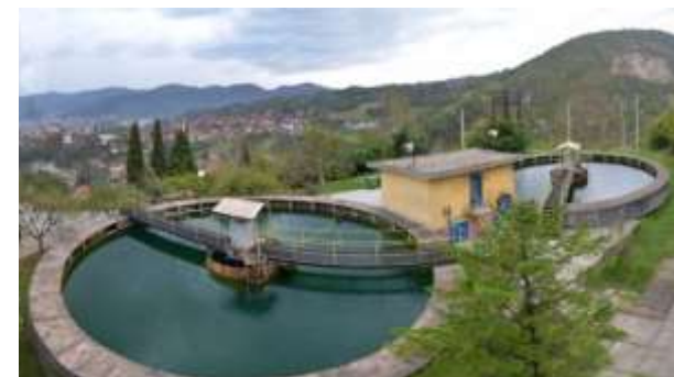
Slika 15. Postrojenje za otpadne vode
