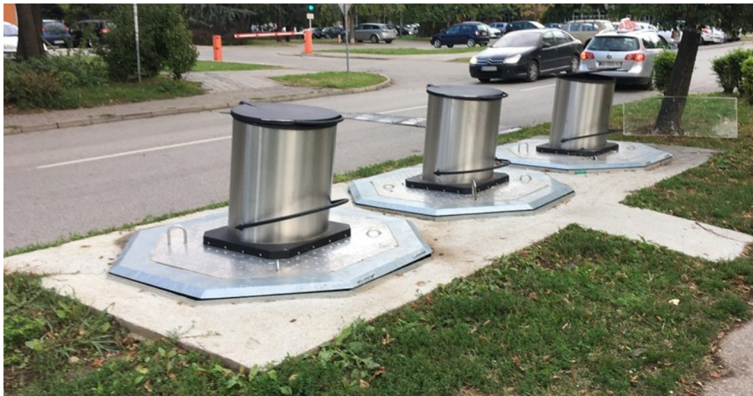
Слика 26 Подземни контејнери
