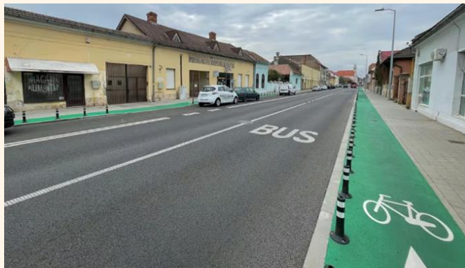
Figura 32. Secțiune de drum reabilitată cu finanțare BERD, cu bandă prioritară dedicată autobuzelor și piste de biciclete paralele și sigure
