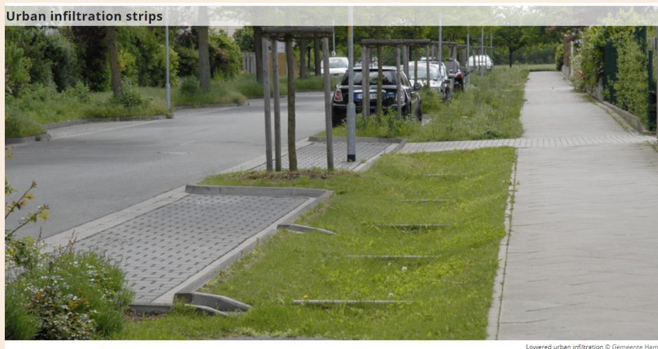
Figura 19 - Potențială modernizare a străzilor din cartiere pentru a facilita absorbția apei (Sursa: Urban Blue-Green Grids)
