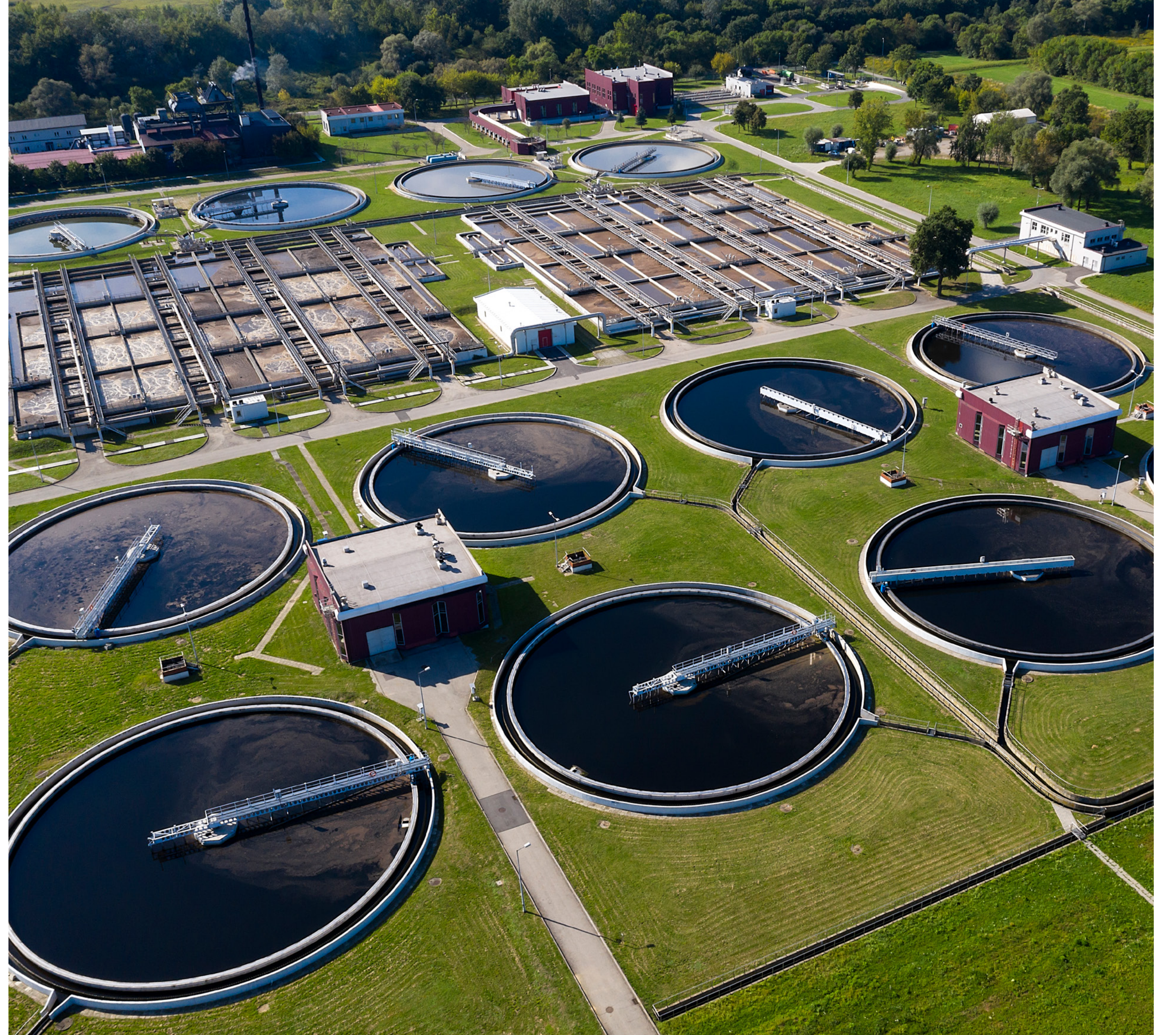
Atıksu Arıtma Tesisi, Getty Images
