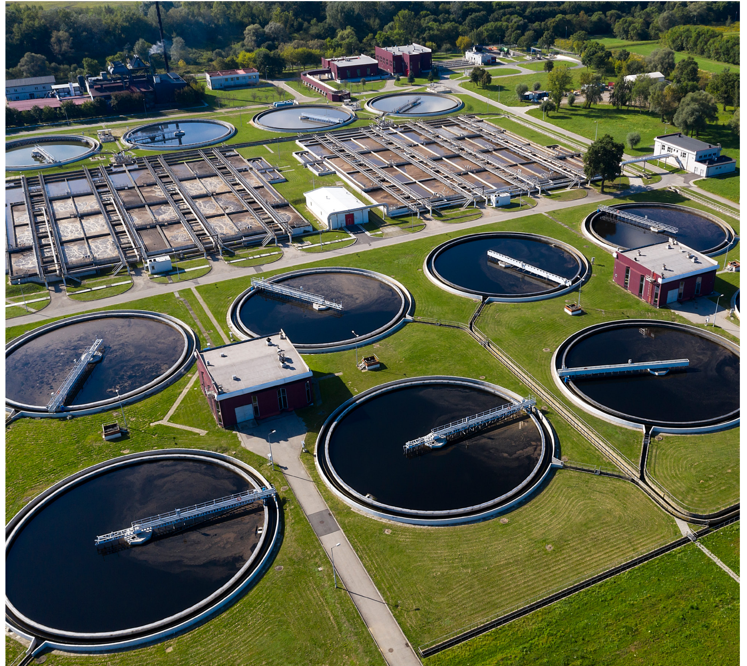
Station d'épuration des eaux usées, Getty Images
